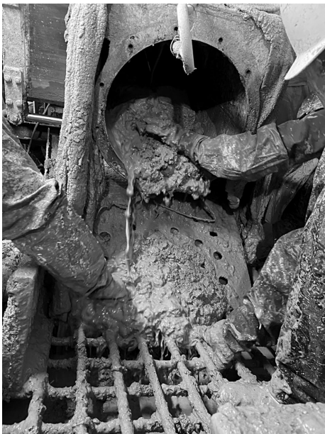
写真-3 凝集された掘削土砂
