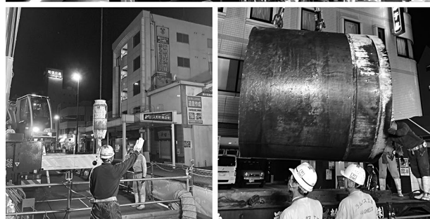
写真-6 夜間作業での掘進機の回収状況
