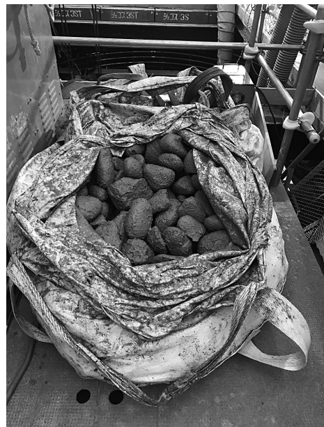
写真-4 坑外へ搬出された土砂
