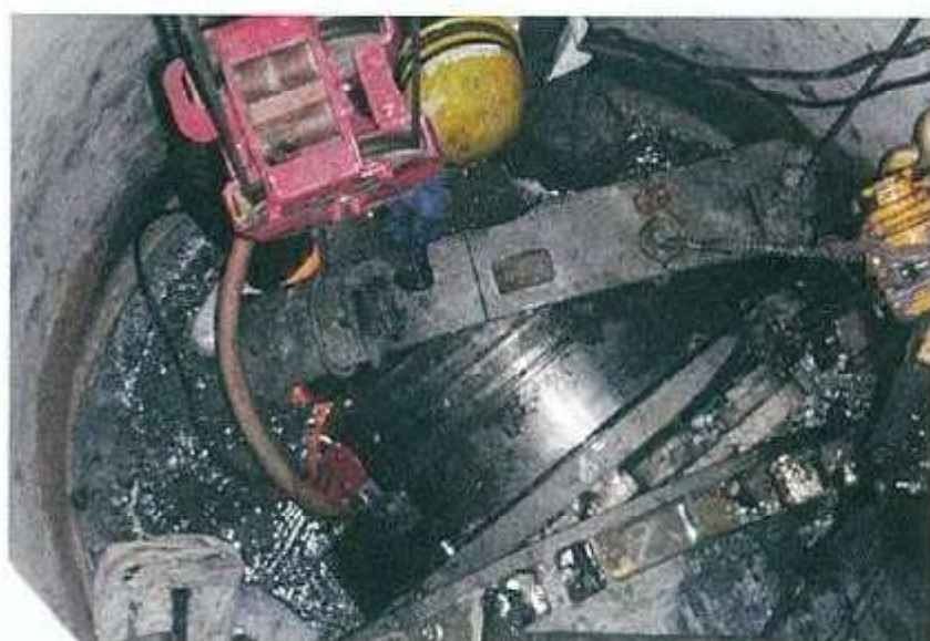
写真-9 分割構造としたバルクヘッド
