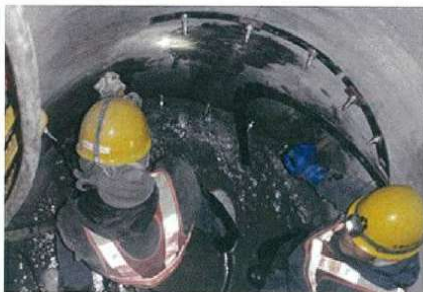
写真-5 マンホールに坑口をアンカーにて固定
