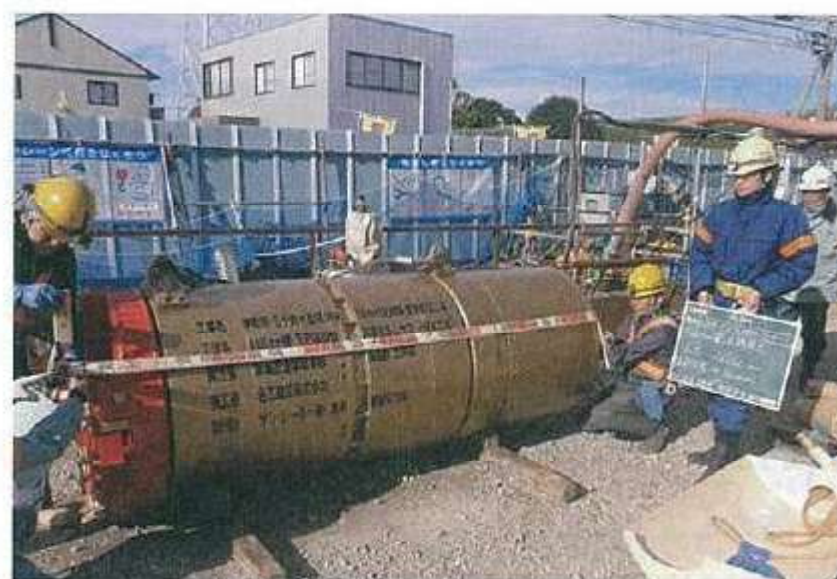
写真-2 分解回収型掘進機
