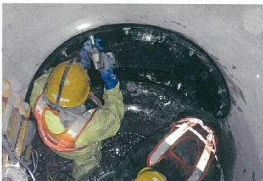
写真-6 コア抜き後坑口ゴム取付け状況
