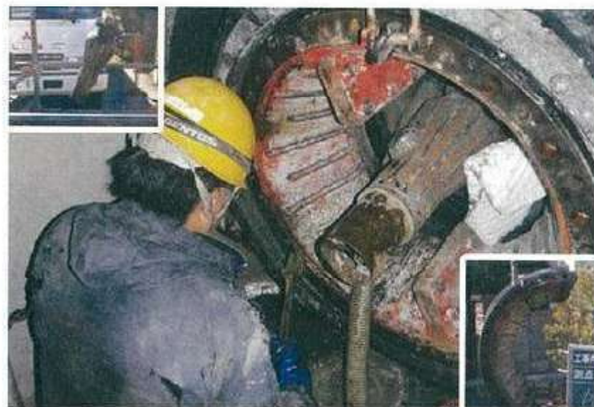
写真-8 二次破碎装置の分解作業状況
